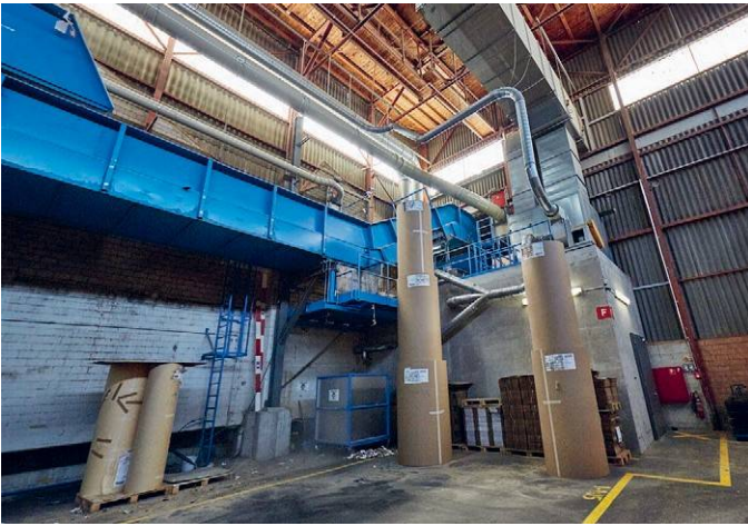
Крупномасштабная система удаления отходов работает в непрерывном режиме 24/7 на производстве гофрокартона.
